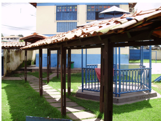
Foto 1: Vista do prédio esquerdo. Vê-se a passarela que o liga ao prédio direito, onde fica a administração da instituição.
